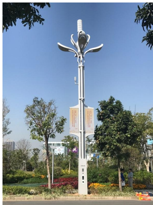
深圳前海紫荆园智慧路灯项目
